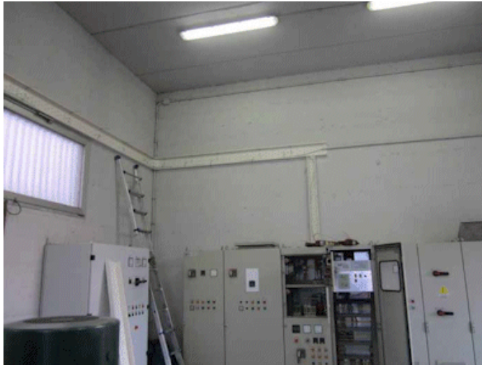
Telecontrollo Impianti di sollevamento
